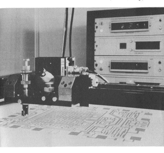
Questa apparecchiatura serve a controllare le caratteristiche elettriche del chip quando ancora esso fa parte del wafer. I puntini bianchi sono chip difettosi e pertanto scartati.
